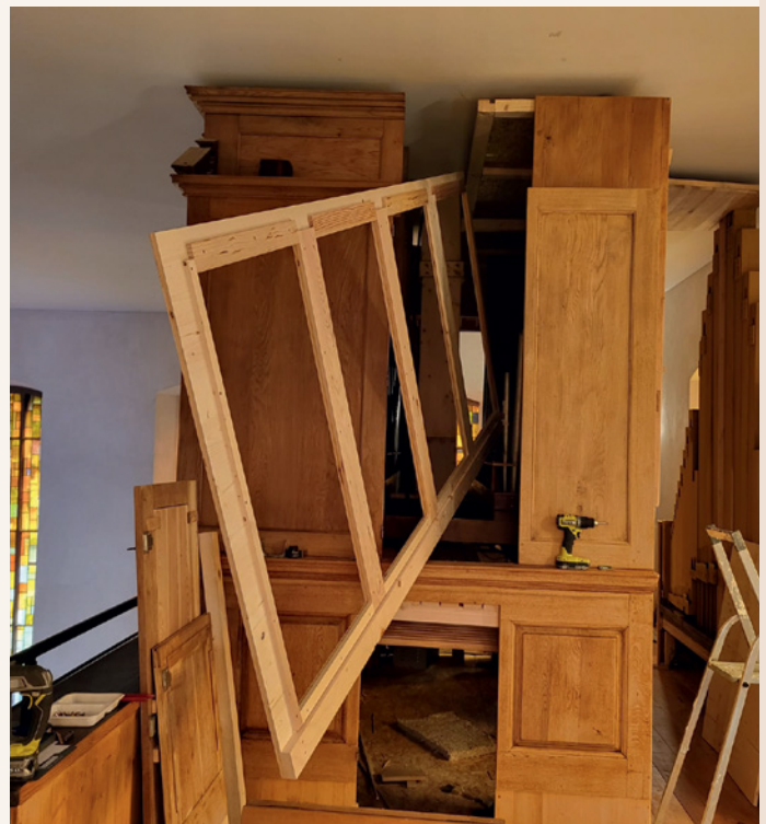
Plusieurs travaux cet été : avancement du local de stockage du foyer de Seebach et assemblage des cloisons intérieures de l'orgue pour l'installation de la boîte d'expression. Un merci aux bénévoles !
